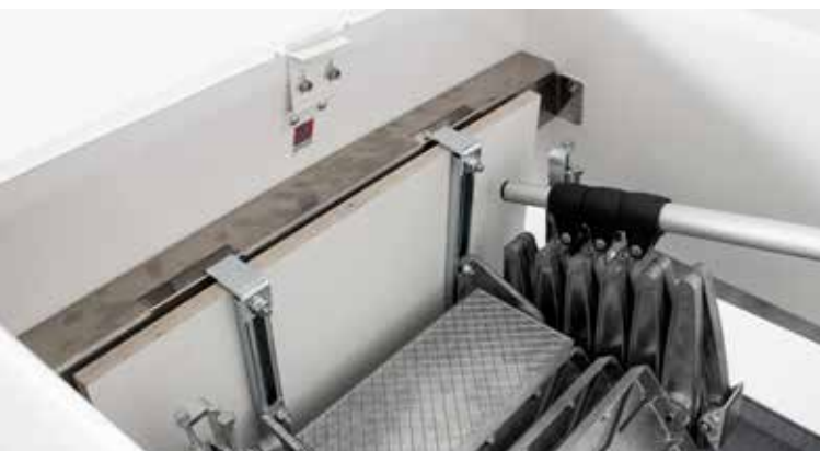
1. Schritt: Treppe in die Vorrichtung des Dachausstiegs einhängen
